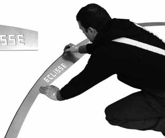
10c) Tracer l'arrondi au sol cote "0" en suivant le bord du gabarit.
